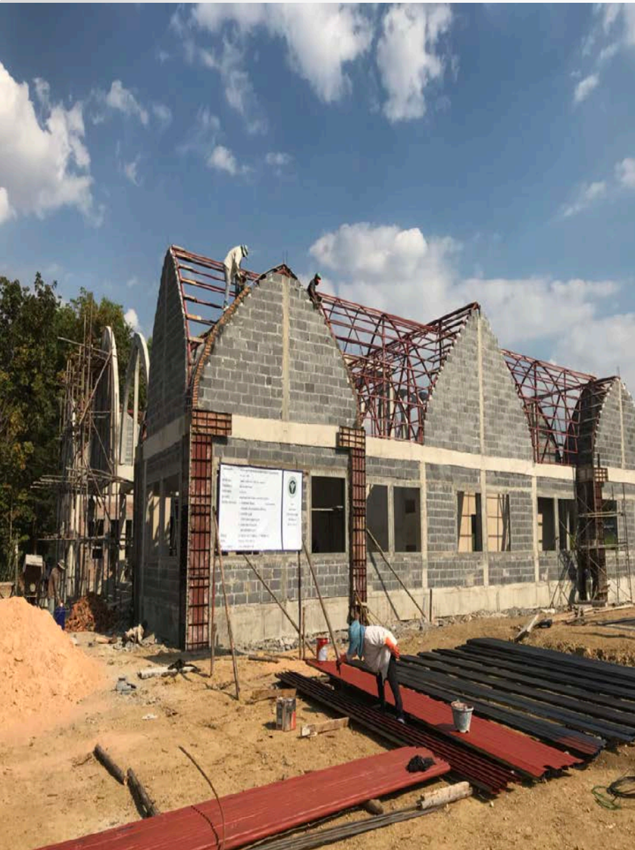
อาคารแปรรูปสमुนไฟ ดำเนินการงวด 3 (40%) ณ 9-01-61
