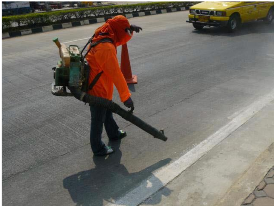
ภาพแสดงการใช้เครื่องเป่าลม ทำความสะอาด
