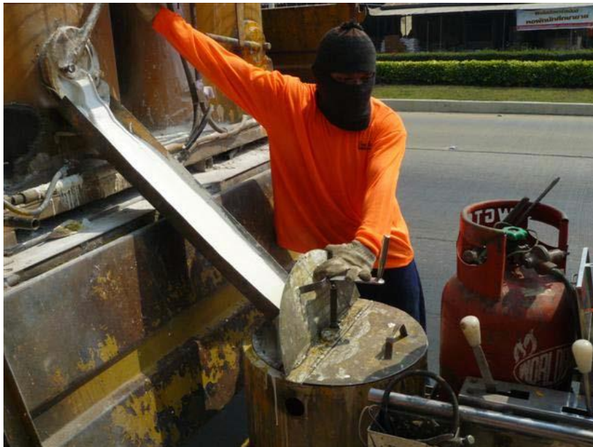
ภาพแสดงการนำวัสดุเทอร์โมพลาสติกหลอมเหลว เทใส่ในเครื่องตีเส้นจราจร
