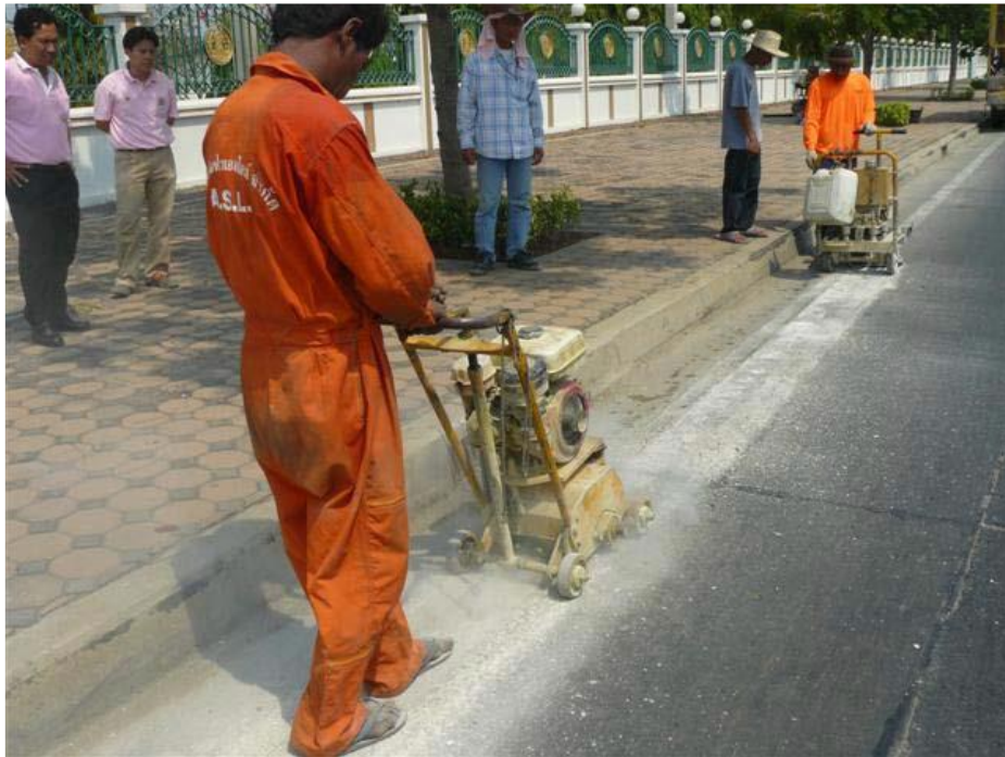
ภาพแสดงการใช้เครื่องจักรกลลบเครื่องหมายจราจรบนผิวทาง (แบบหยาบและละเอียด)
