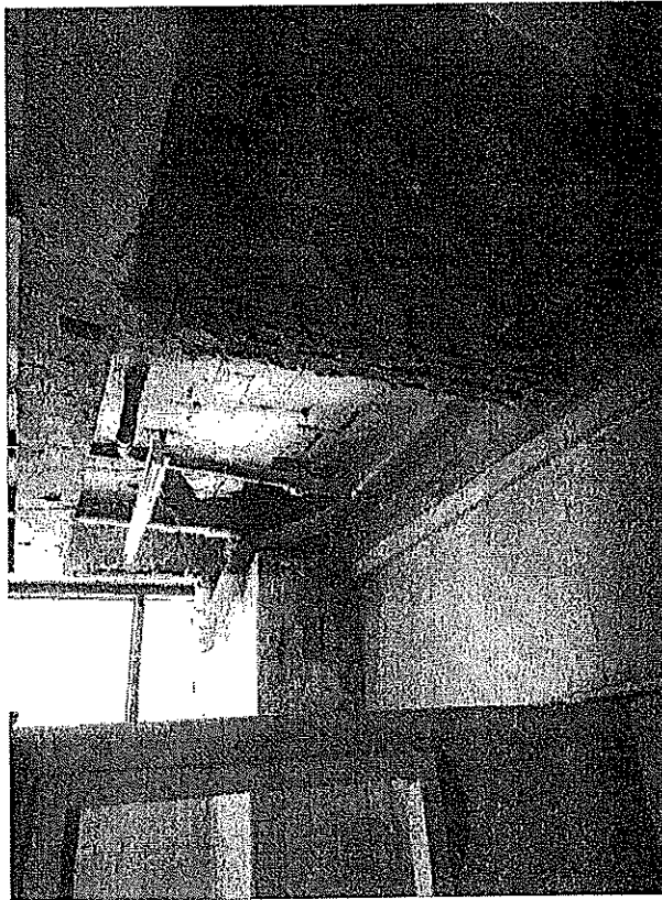
รูปภาพความเสียหายที่เกิดจากความชื้นทำให้เหล็กเกิดสนิมและดันคอนกรีตให้แตกร้าวหลุดร่อน จำเป็นต้องรีบซ่อมแซมก่อนที่ความเสียหายจะเพิ่มเติมไปในส่วนต่างๆ
